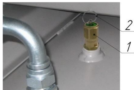
Рисунок 11 – Клапан предохранительный пружинного типа
